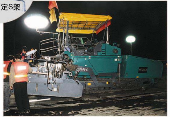
北京三环路摊铺施工现场（机载型实例）
