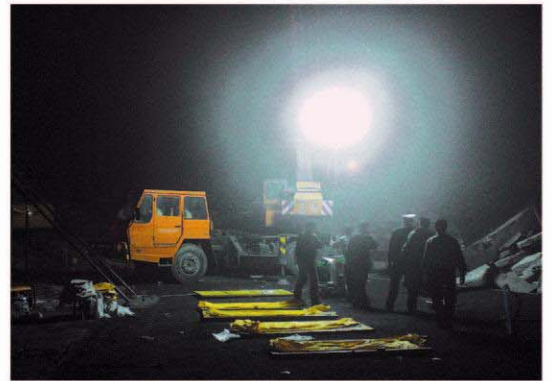
四川什邡市莹华镇中学救援现场
